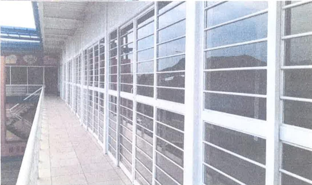
AREA DE CAJONES DE ESTACIONAMIENTO, CUMPLIENDO CON REGLAMENTO DE CONSTRUCCIONES, AL AIRE LIBRE, SE OBSERVAN PASILLOS COMPLETAMENTE LIBRES QUE COMUNICAN INMEDIATAMENTE A ESCALERAS PLANTA BAJA, DE LOCALES COMERCIALES 6,7,8 CON SU ESTRUCTURA EN ACERO. SE RECOMIENDA COLOCAR EN VENTANERIA PELICULA INASTILLABLE EN VIDRIOS.
