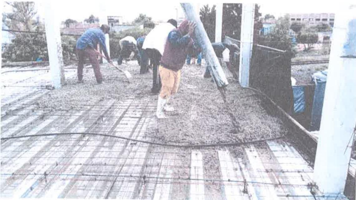
**SISTEMA DE LOSAS DE ENTREPISO CON LOSACERO, Y COLADO DE ESTAS CON CONCRETO Premezclado bombeado, con malla electrosoldada, debidamente permeada.**
