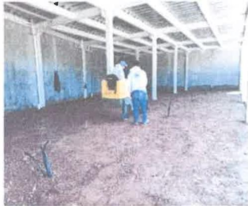
SISTEMA DE PISOS PLANTA ALTA ( CON LOSA-CERO DE ENTREPISO, ASI COMO SISTEMA DE PISOS EN PRIMER PLANTA CON RELLENOS COMPACTADOS CON MEDIOS MECANICOS COMO ELEMENTOS ESTRUCTURALES EN MONTEN EN CAJA ASI COMO VIGAS IPR 6"X4 SOPORTANDO SISTEMA DE PISOS EN LOCALES COMERCIALES 6,7,8 EN PLANTA ALTA.
